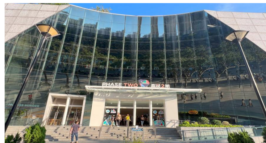
翻新後的入口增設無障礙通道
