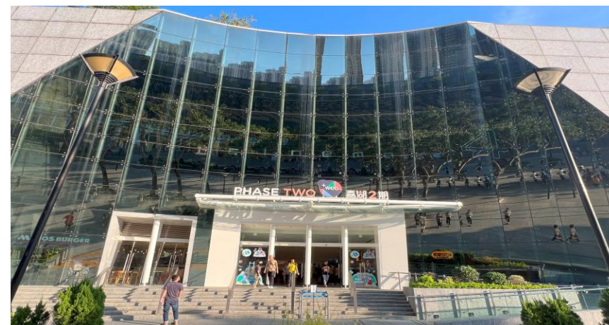
翻新后的入口增设无障碍通道
