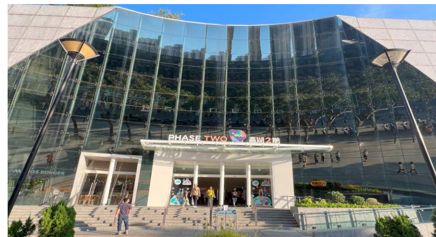
翻新後的入口增設無障礙通道
